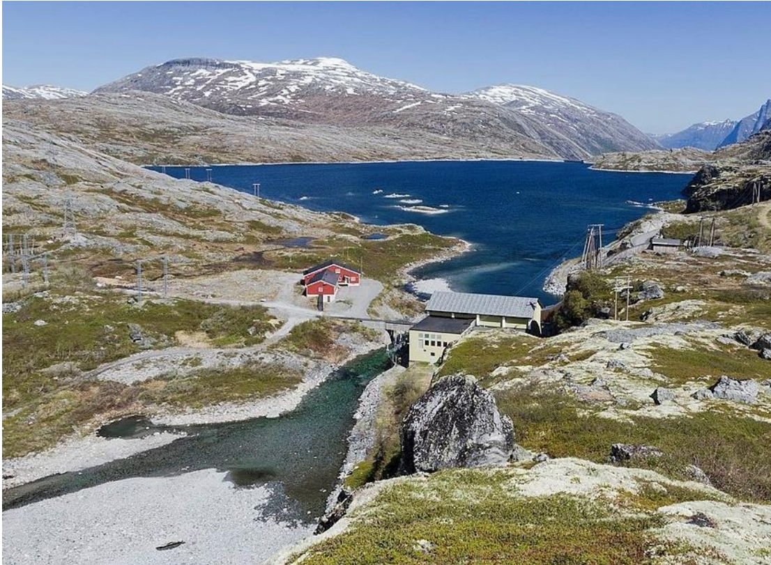
Kraftverk ved Holbuvatnet Foto: Simo Räsänen
